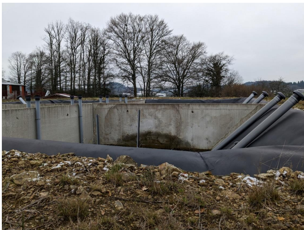
Vue des 4 bassins tournant de phytoépuration
